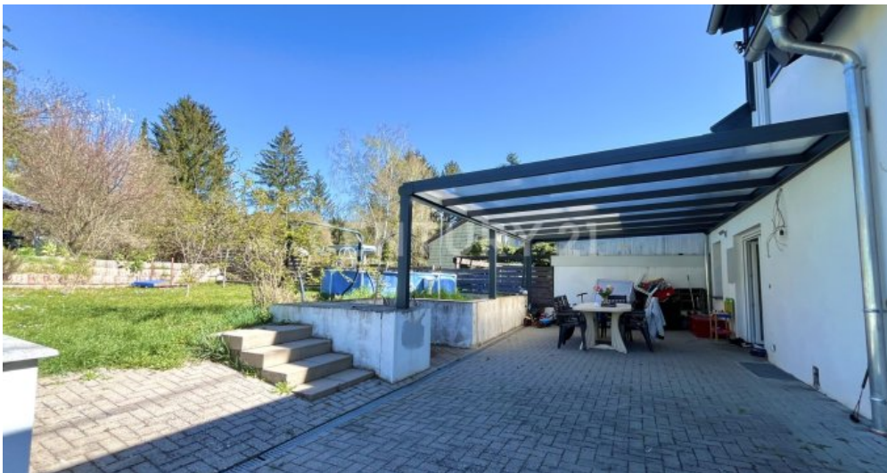
Blick auf überdachte Terasse mit integrierter Grillecke
