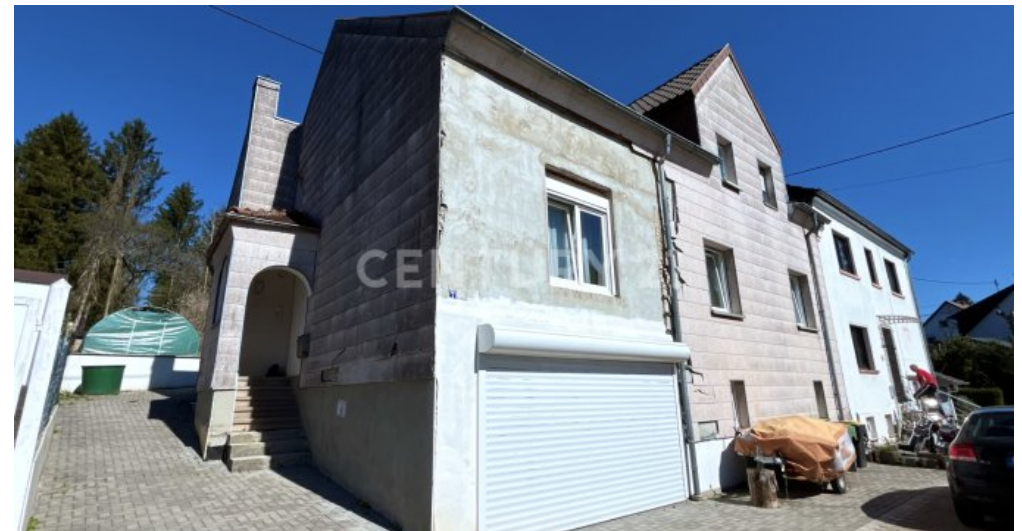
Frontansicht mit Garage
