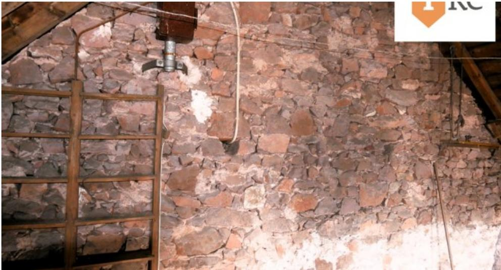
Bruchsteinmauerwerk - Giebel
