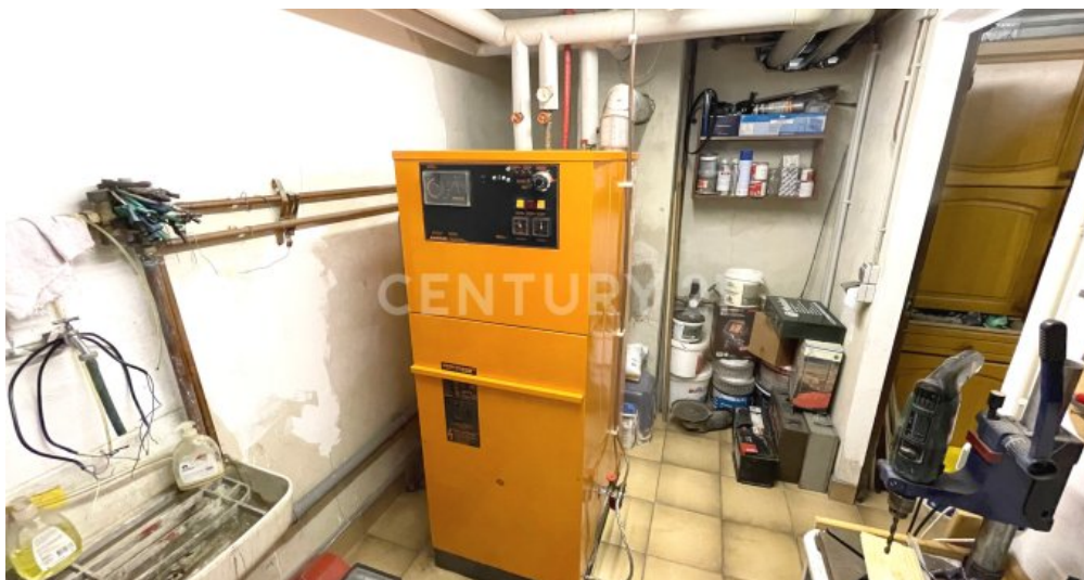
Heizungskeller/Werkstatt aus der anderen Richtung
