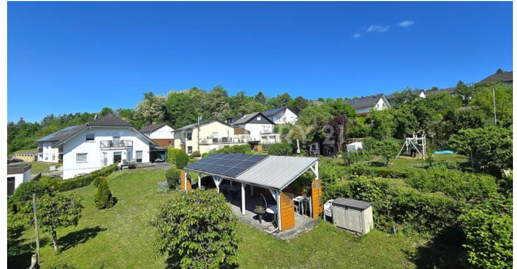
Gartenbereich mit Blick auf den Pavillon mit PV- Anlage
