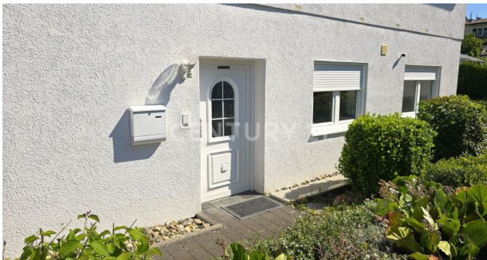
Eingang zur Einl
