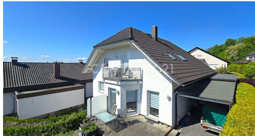
Rückansicht des Hauses mit Blick zur Terrasse
