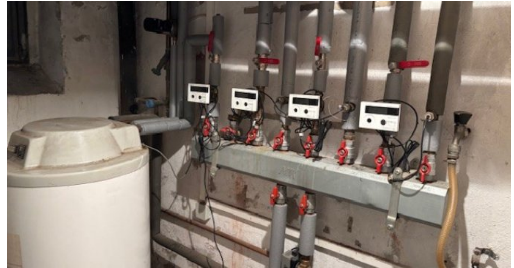
Heizungszähler getrennt
