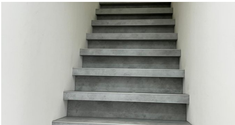
Treppe zum DG
