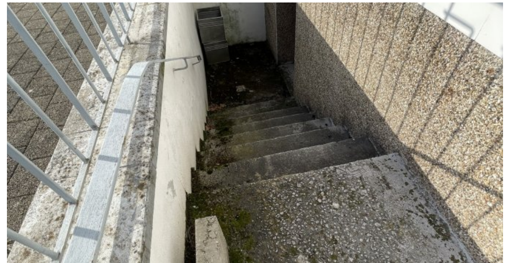
Zugang zum Kellergeschoß
