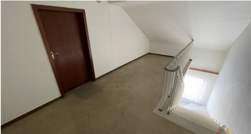
Zugang zum Dachboden
