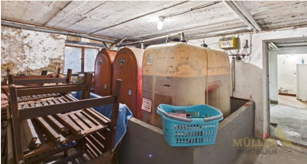
Öltanks ud Abstellraum
