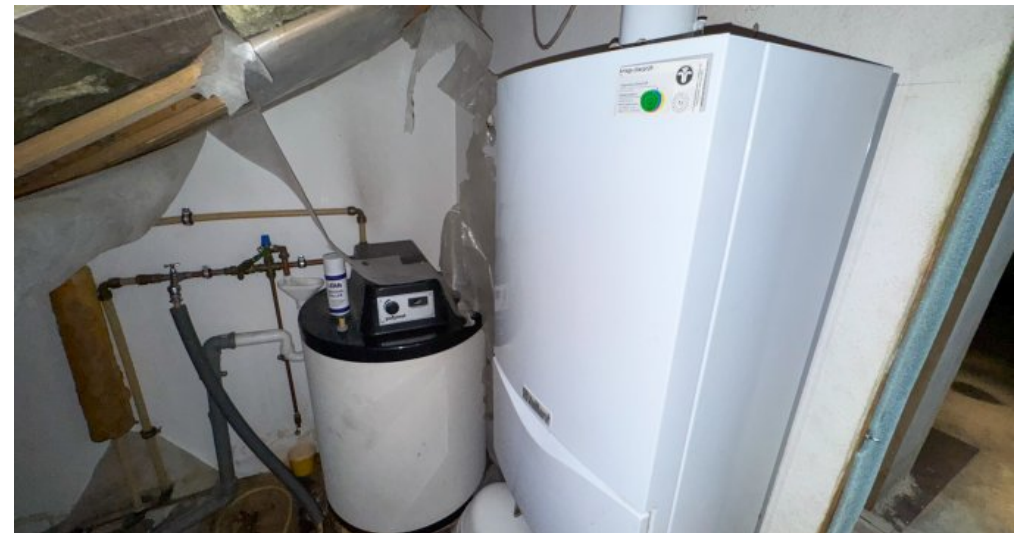
Heizung unterm Dach
