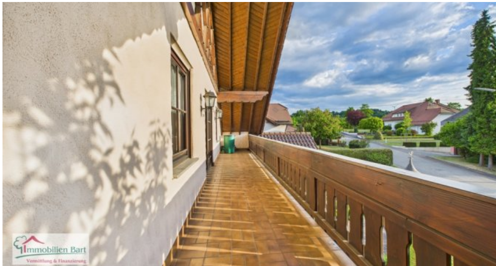
überdachter Balkon Westseite
