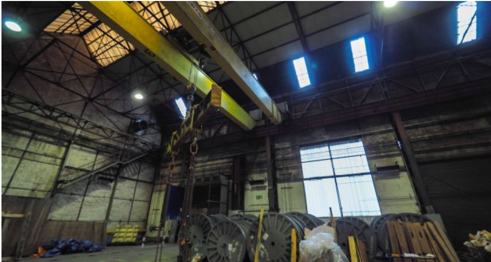
Industriehalle mit Kranbahn
