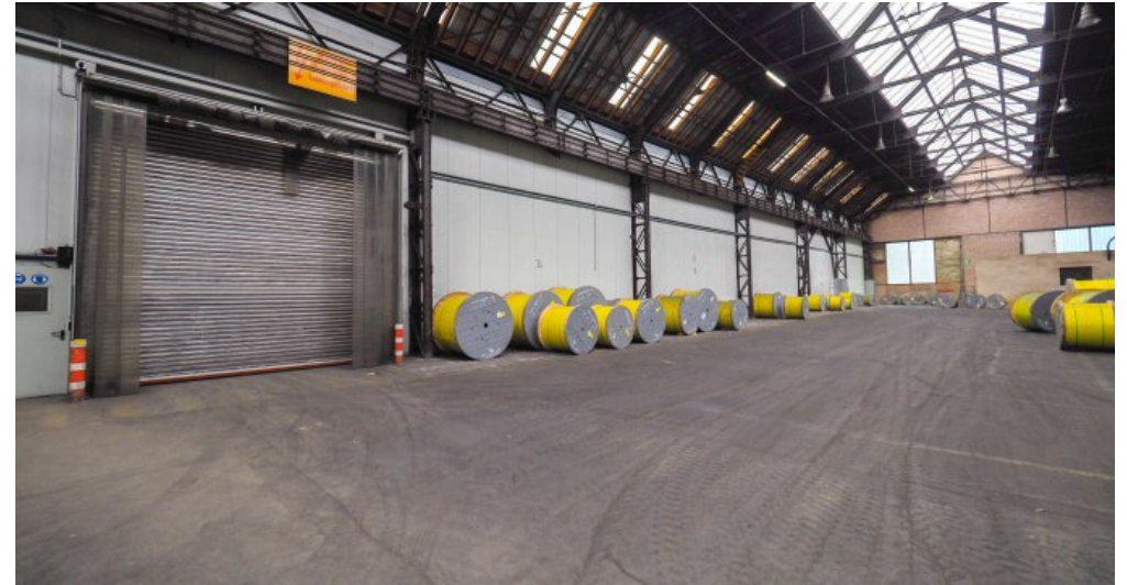
Industriehalle mit Kranbahn
