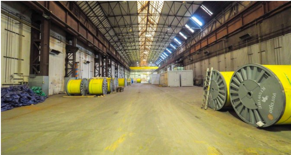
Industriehalle mit Kranbahn
