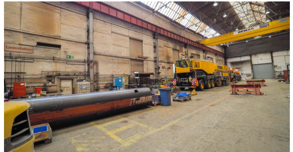
Industriehalle mit Kranbahn
