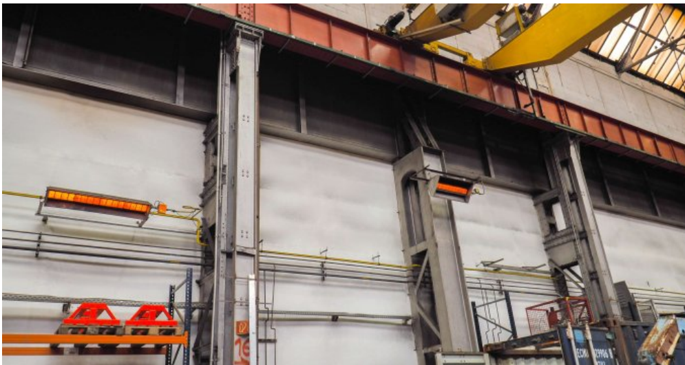
Industriehalle mit Kranbahn
