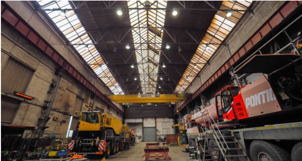
Industriehalle mit Kranbahn
