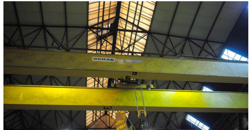
Industriehalle mit Kranbahn
