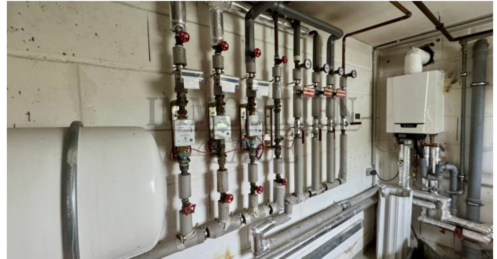
Wärmemengenzähler
