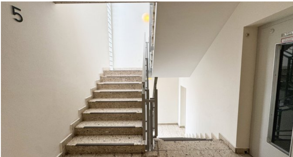
Treppenhaus mit Aufzug
