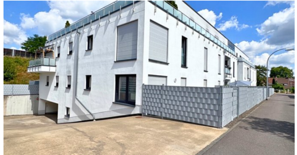
Einfahrt zur Tiefgarage
