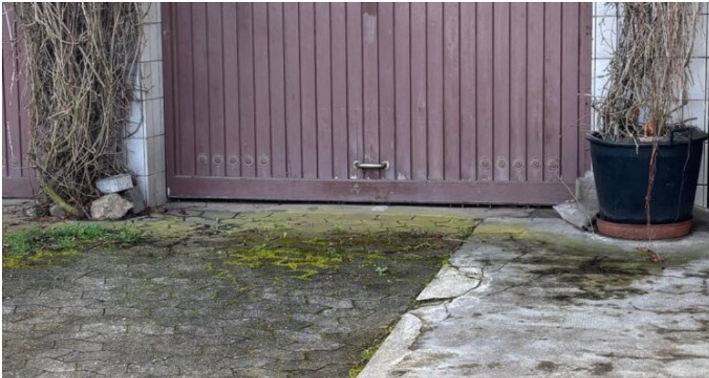
Garage mit Stellplatz davor
