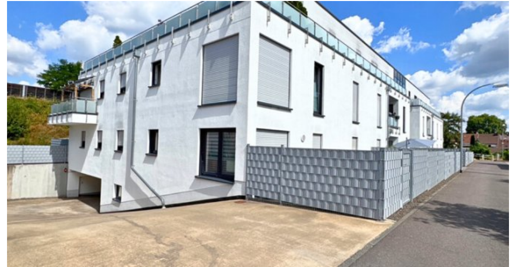
Einfahrt zur Tiefgarage
