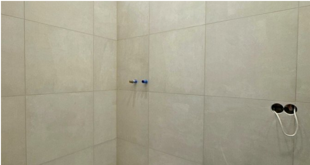
Dusche mit Oberlicht
