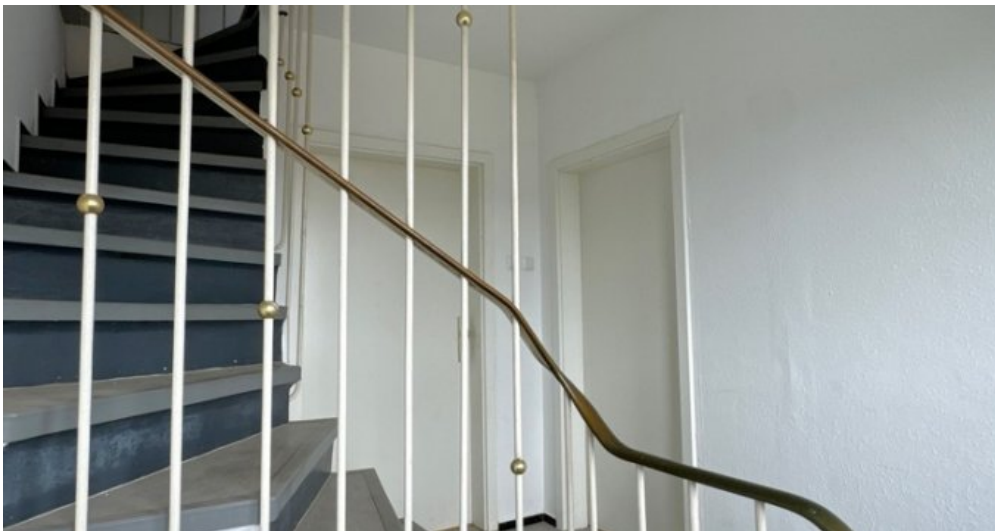
Treppe zum 2.OG und DG
