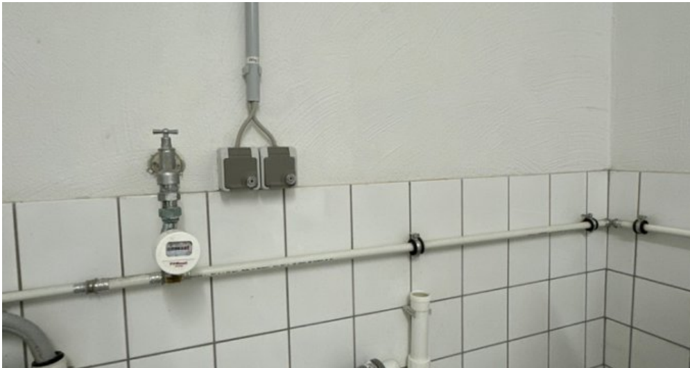
Waschmaschinenanschluss
