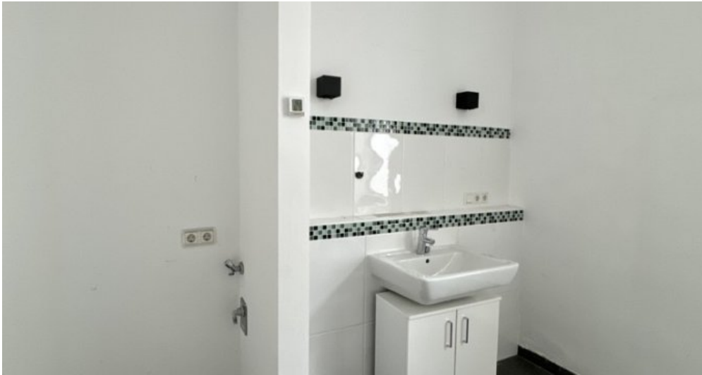
Waschmaschinenanschluss
