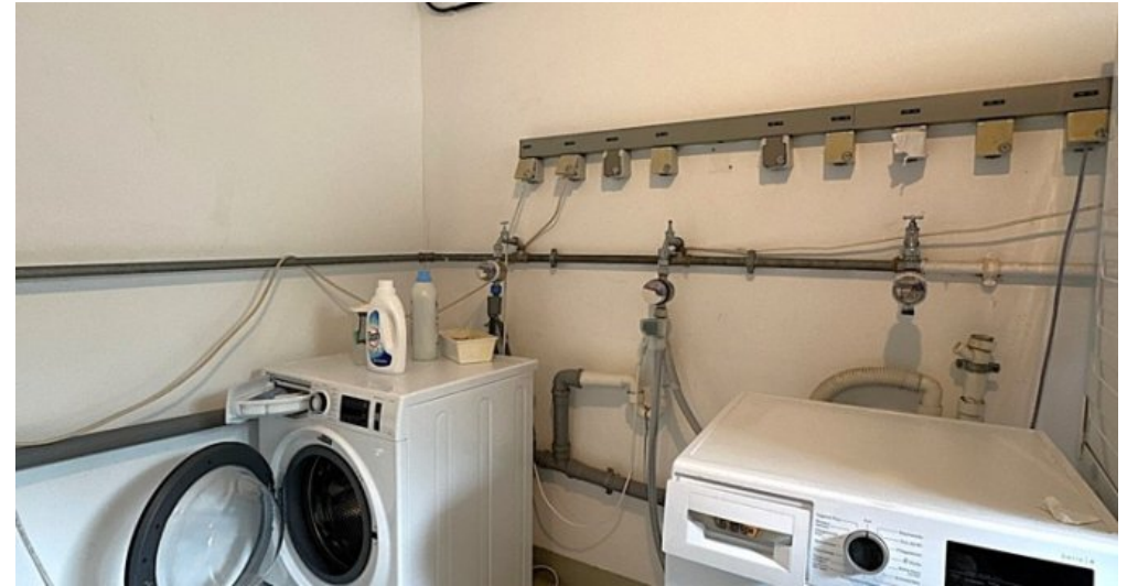
Wasch- und Trocknungsraum
