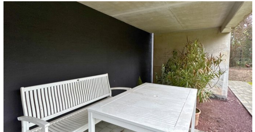
Gemeinschaftliche überdachte Terrasse
