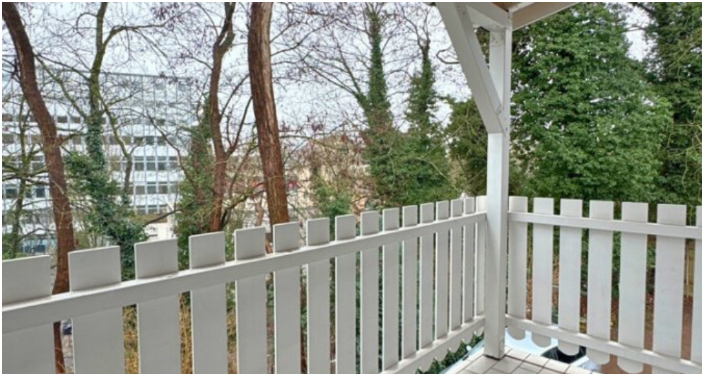
Überdachter Balkon OG
