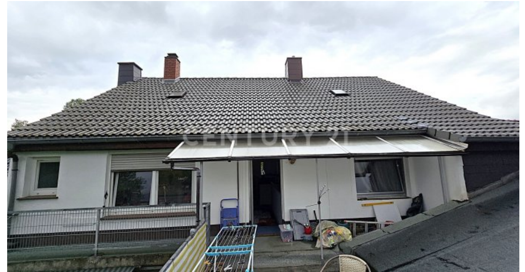
Rückseite der Dachterrasse und Blick zum neuwertigen Dach
