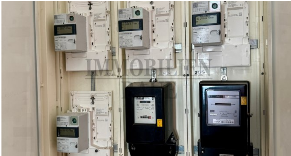
Stromzählerschrank
