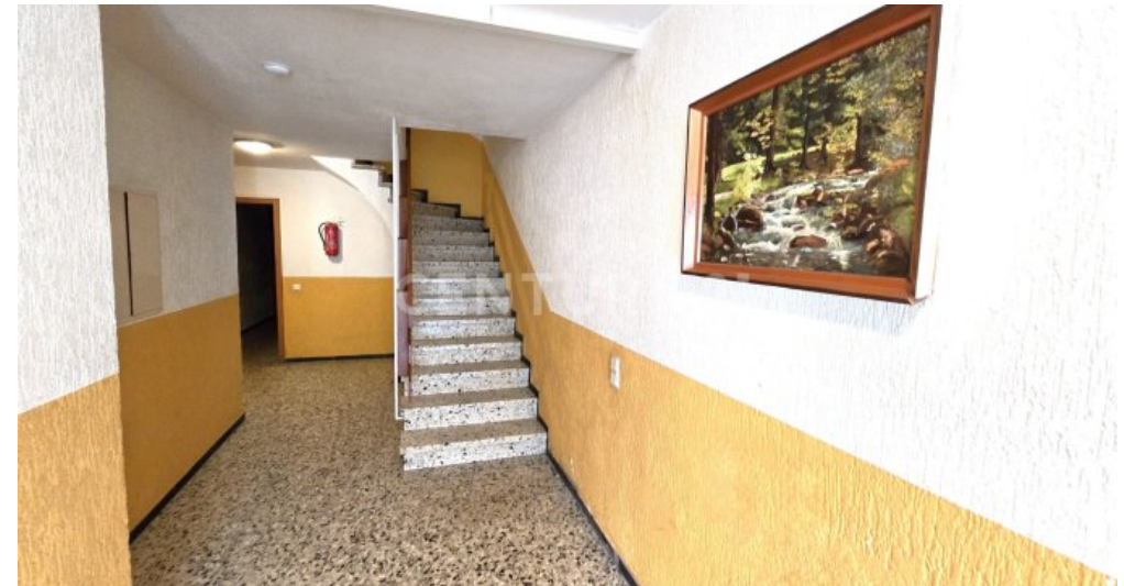
Flur im EG mit Treppenhaus zum OG
